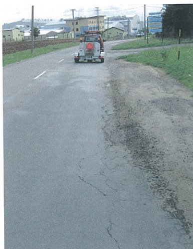
F18, km 65,580 síťové trhliny, plošná deformace, olámaná krajnice
