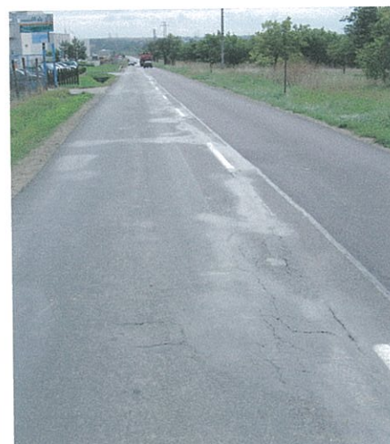
F20, km 65,710 síťové trhliny
