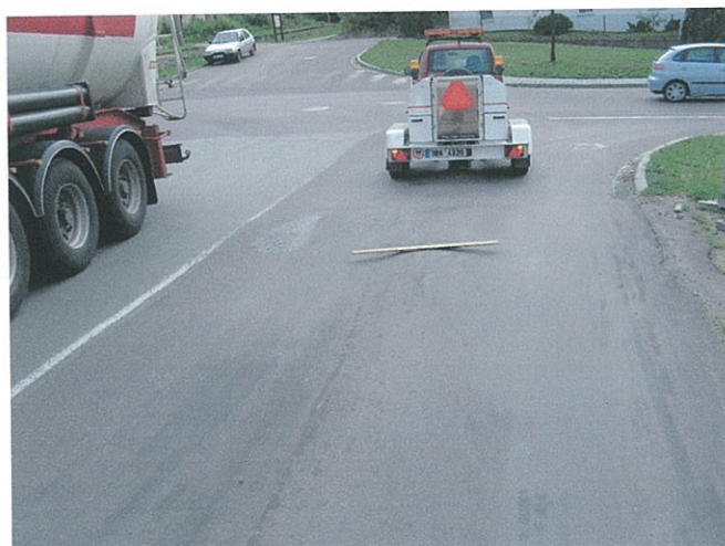
F11, km 65,340 výrazné plošné deformace před křižovatkou sil.II/361
