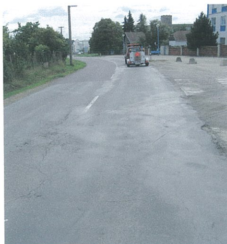
F16, km 65,470 mozaikové trhliny, vysprávkky, nepravidelné hrboly
