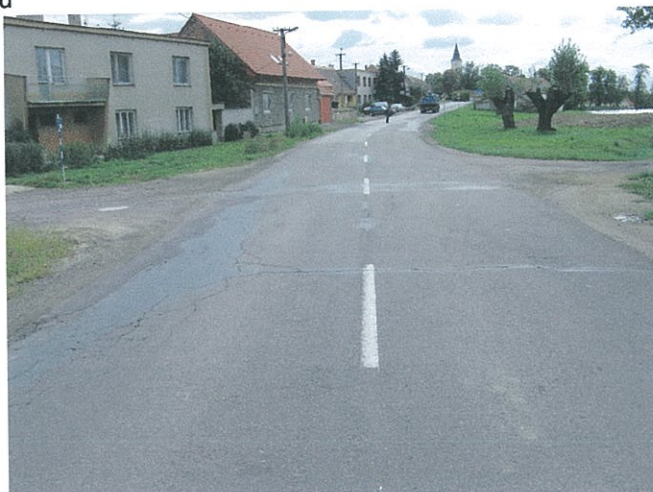
F04, km 65,100 síťové trhliny, příčné trhliny
