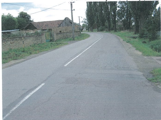
F02, km 65,000 příčný pokles, síťové trhliny
