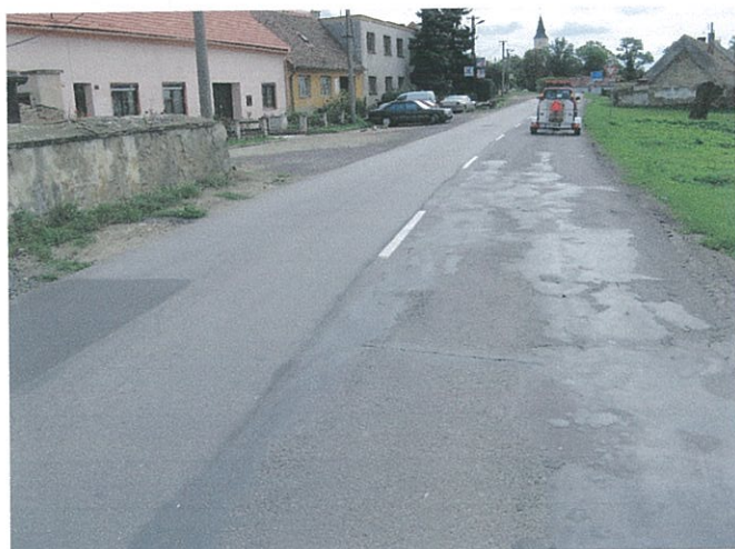
F07, km 65,170 vlevo oprava povrchu po stavbě kanalizace, vpravo hloubková koroze, mozaikové trhliny a vysprávkky
